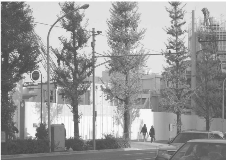
工事が始まった高層マンション
