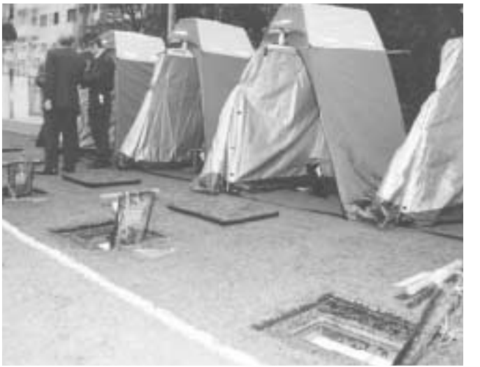
設置されている災害用トイレ
