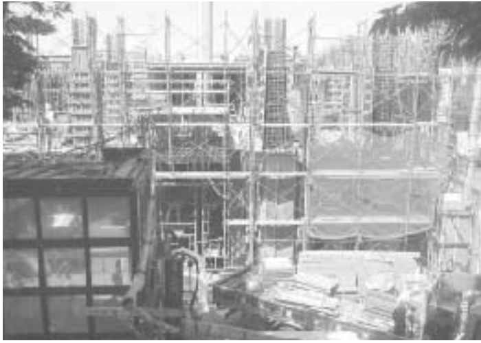
建設中の表参道TTSビル
